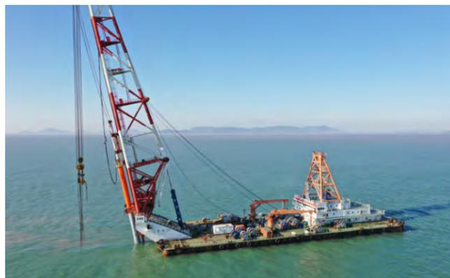
国电电力象山 504 兆瓦海上风电项目“桩 20”打桩船正在沉桩作业
